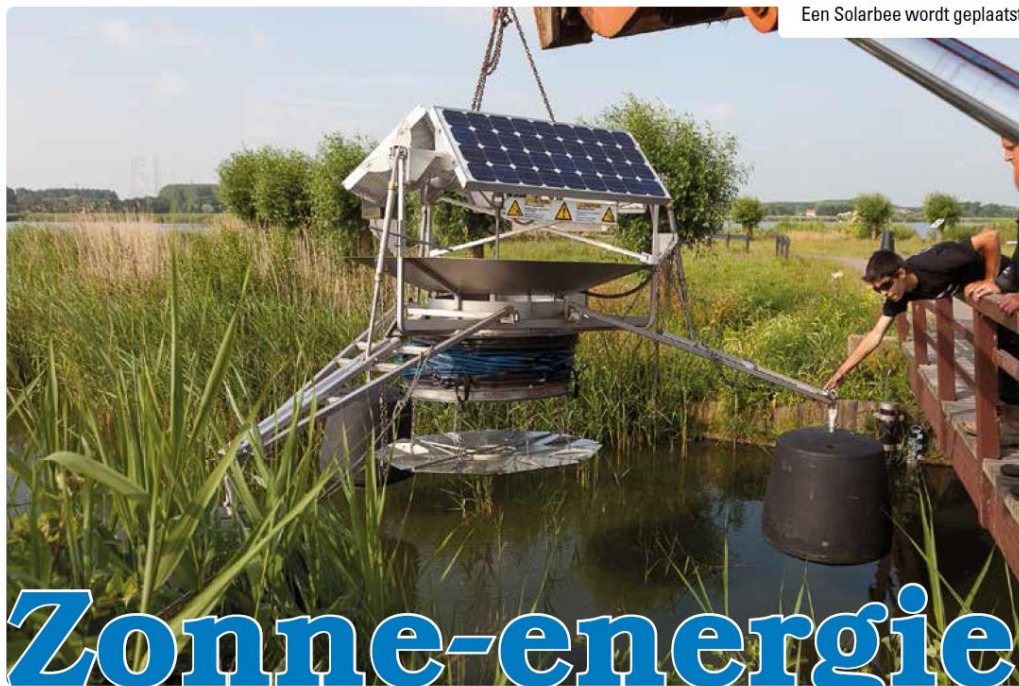
Een Solarbee wordt geplaatst.
