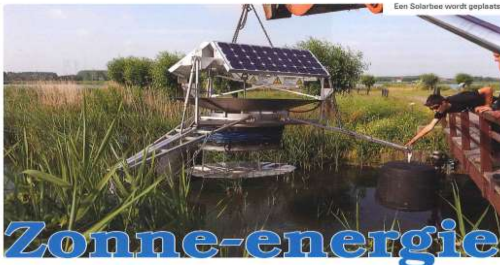
Een SolarBee wordt geplaatst.
